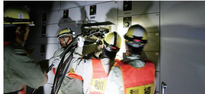
夜間における電源ケーブル接続訓練
