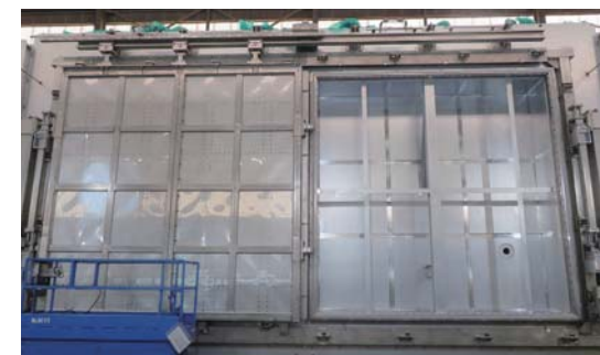
左側がスライド扉でブローアウトパネル「閉」の状態の写真
