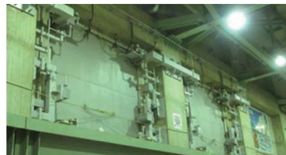
原子炉建屋内から見たブローアウトパネル
