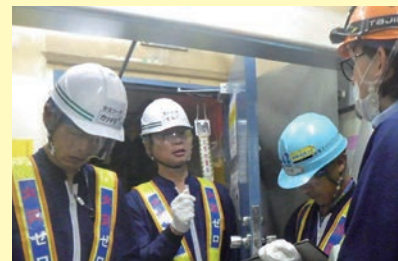
発電所員だけでなく、本店・敦賀発電所の現場経験者で構成された火災撲滅推進チームによる現場確認の様子
