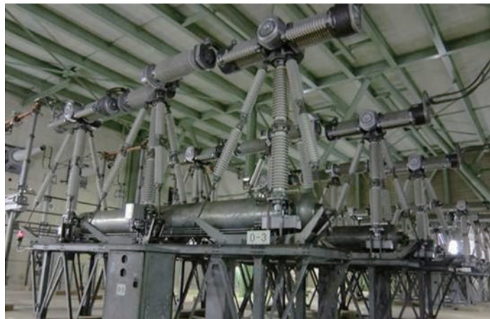
図3 ガス絶縁開閉装置（GIS）更新後
