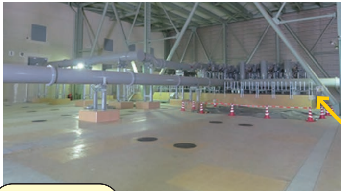
図3 ガス絶縁開閉装置（GIS）更新後
