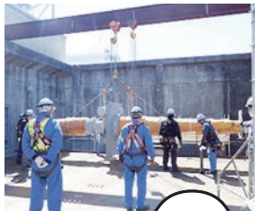
図4 ケーブル撤去の様子（屋外）
