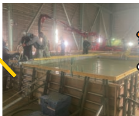
図5 基礎コンクリート打設の様子
