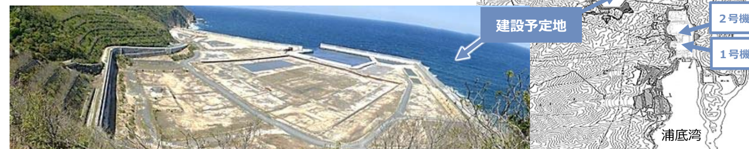
建設予定地の状況 (2021年4月26日撮影)
