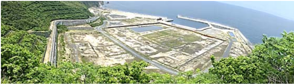
建設予定地の状況 (2021年6月23日撮影)
