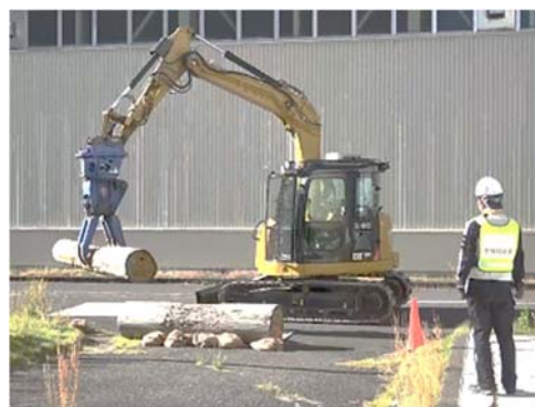
無線重機によるガレキ撤去
