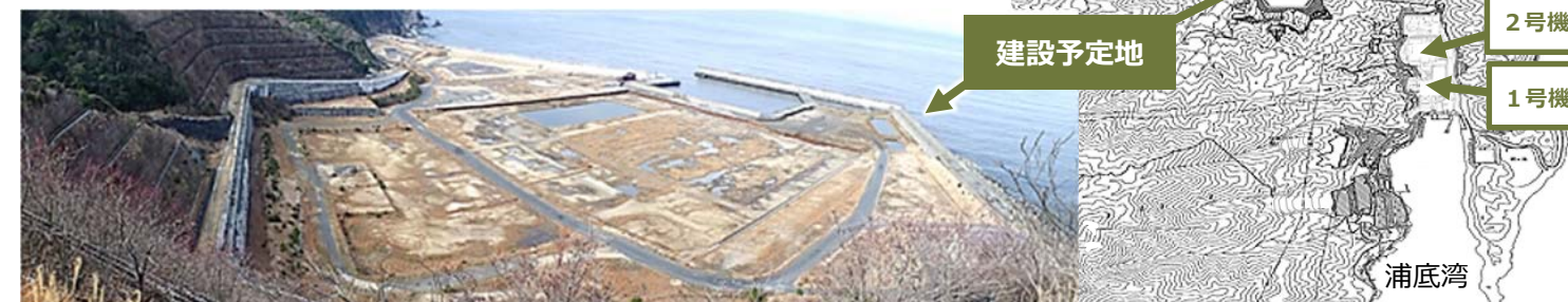
建設予定地の状況(2022年1月25日撮影)
