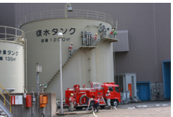
消防車から復水タンクへの水の補給訓練（H23.3.30実施）
