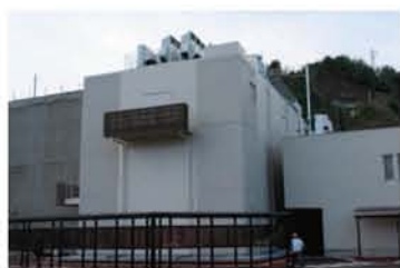
免震構造、耐放射線性を有した 緊急時対策室建屋
