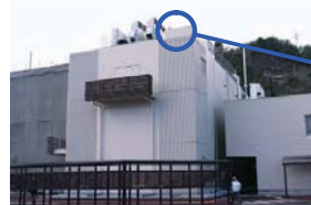
緊急時対策室建屋 (免震構造で、放射線防護対策を講じ 非常用発電機を備えている)
