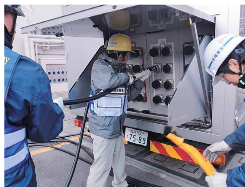
低圧電源車へのケーブルの接続
