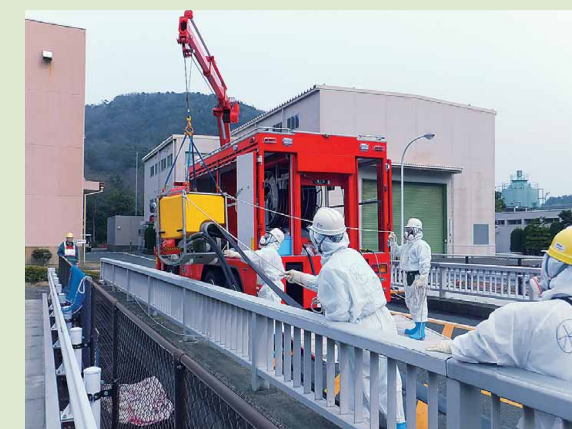
冷却水の送水訓練
