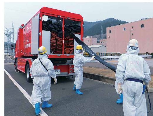
大容量ポンプからの海水を送るためのホースを延長
