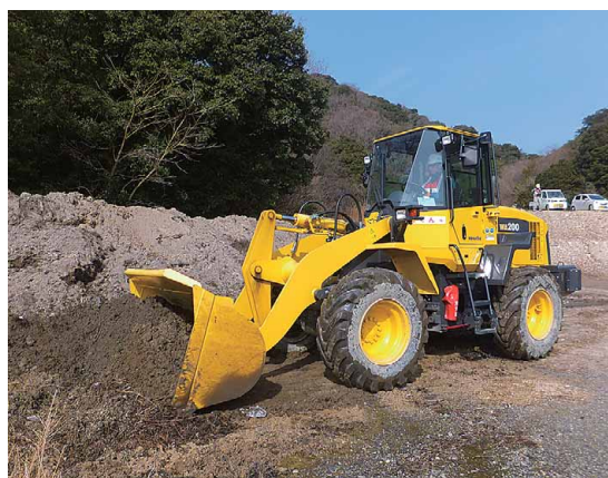
重機（ホイールローダ）にて土砂を撤去
