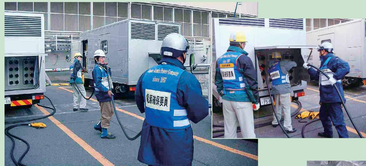
低圧電源車への電源ケーブルの繋ぎ込み訓練
