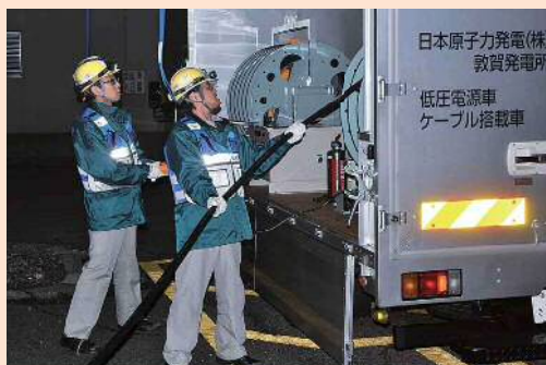
ケーブル搭載車からケーブルの引き出し夜間訓練 (平成27年1月14日)
