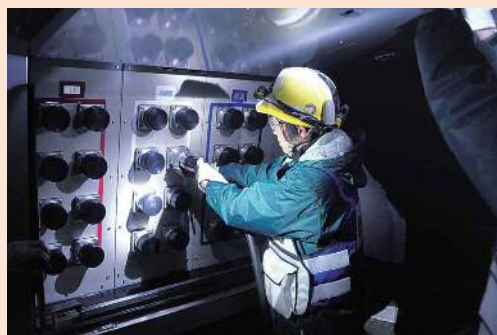
引き出したケーブルを電源車に接続する夜間訓練 (平成27年1月14日)
