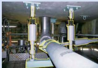
原子炉建屋内の重要配管へのサポーター設置例
