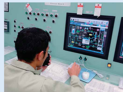
試運転データを採取し、分解・点検後の弁の動作や性能を確認
