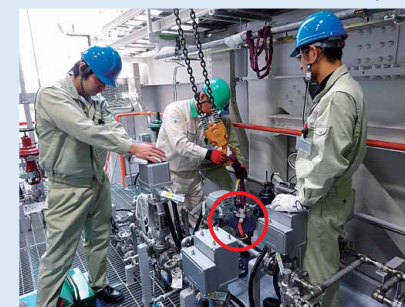
点検後、駆動装置の据え付け
