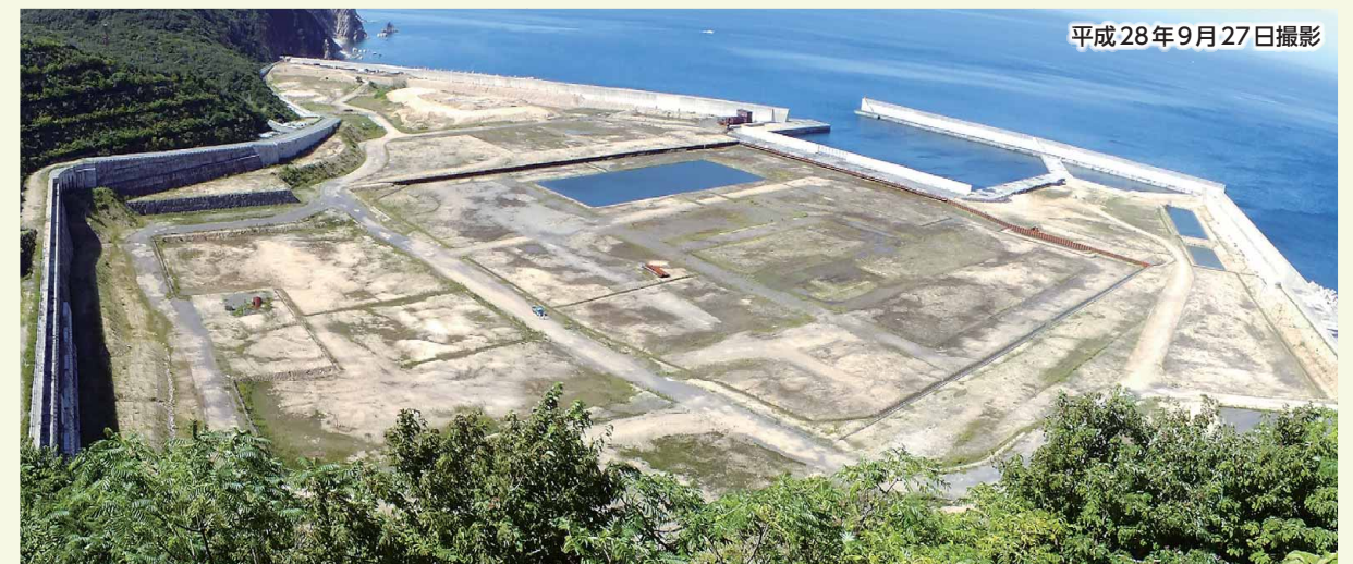
敦賀発電所3, 4号機 増設予定地（埋立完了、維持管理中）
