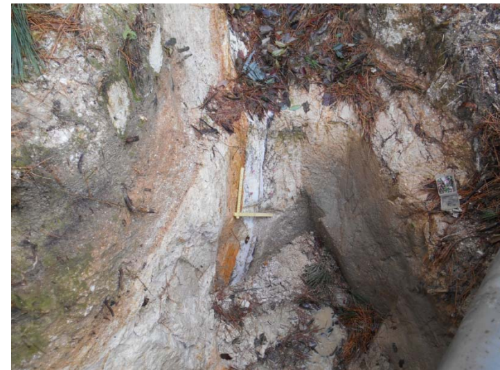
露頭拡幅部下部写真
