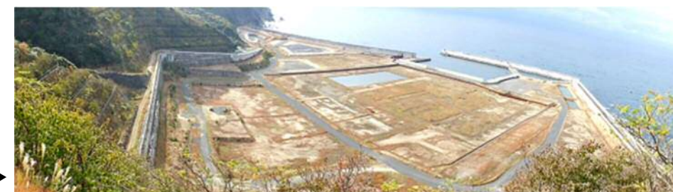
建設予定地の状況（2020年11月26日撮影）▶
