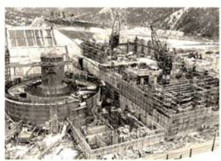
1968年（昭和43年） 敦賀発電所1号機 建設が進む原子炉建屋・ タービン建屋
