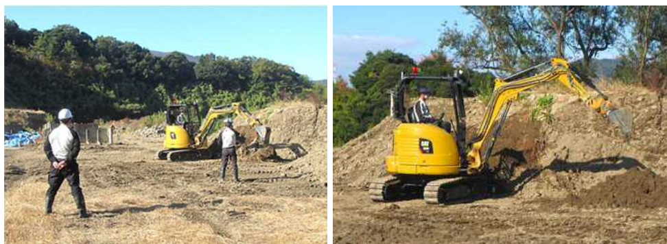
重機による瓦礫・土砂撤去訓練の様子
