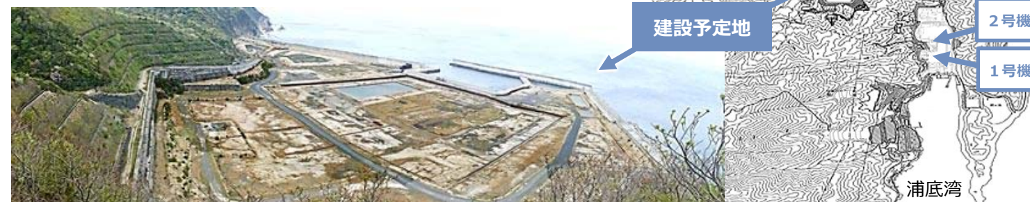
建設予定地の状況 (2022年4月21日撮影)
