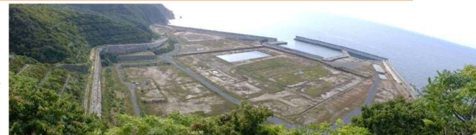
建設予定地の状況(2022年9月26日撮影)
