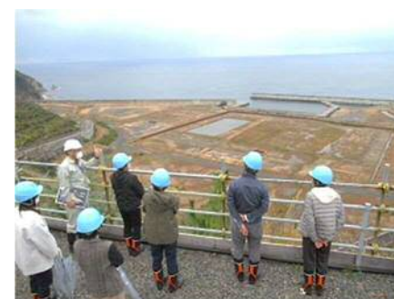
敦賀3,4号機建設予定地見学の様子
