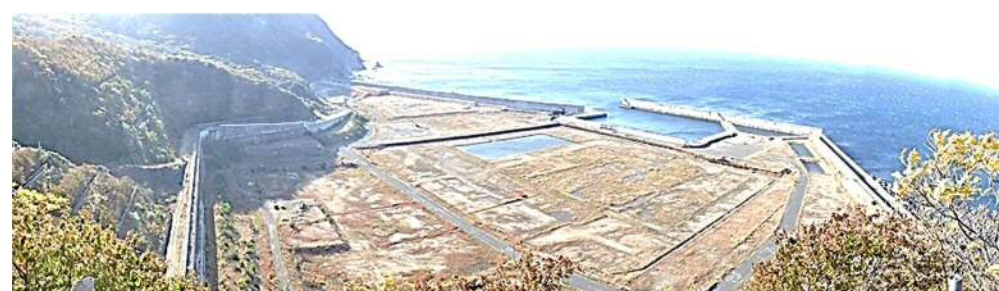
建設予定地の状況(2022年11月28日撮影)
