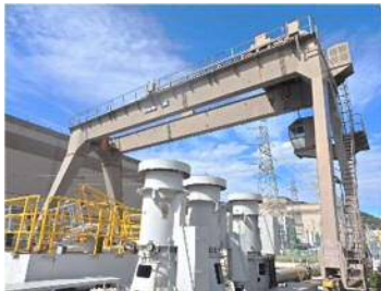
クレーン装置【解体前】
