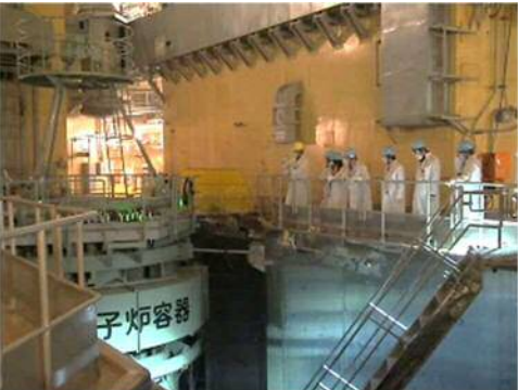
敦賀発電所2号機での格納容器内ご視察の様子
