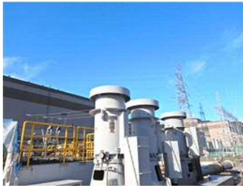
クレーン装置【解体後】
