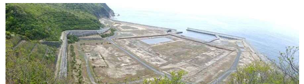
建設予定地の状況（2023年4月25日撮影）
