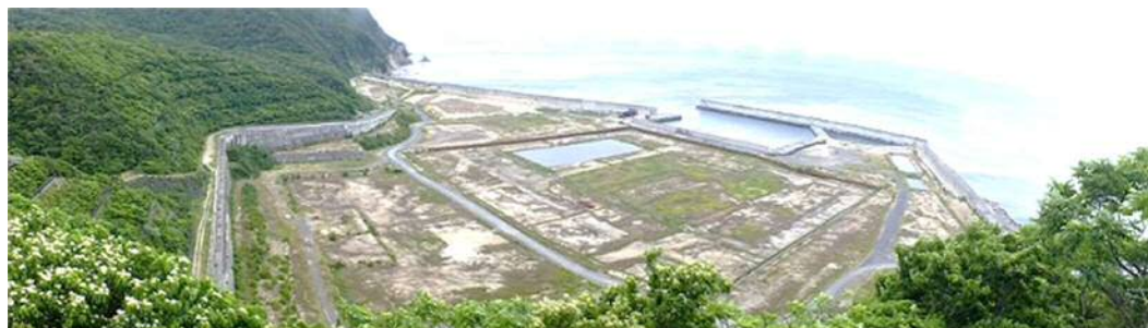
建設予定地の状況 (2023 年 6 月 21 日撮影)
