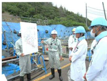
敦賀2号機 D-1 トレンチご視察の様子
