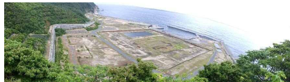
建設予定地の状況（2023年8月17日撮影）
