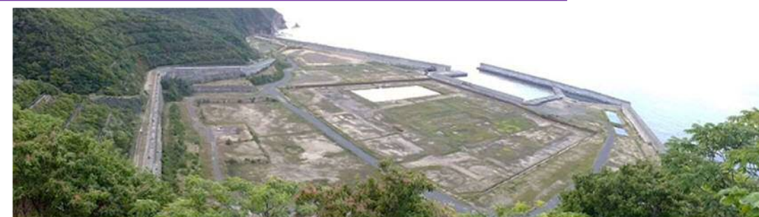
建設予定地の状況（2023年9月25日撮影）
