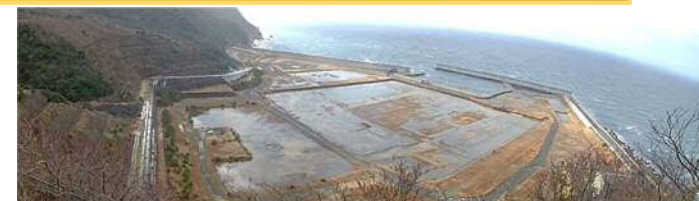
建設予定地の状況（2023年12月25日撮影）
