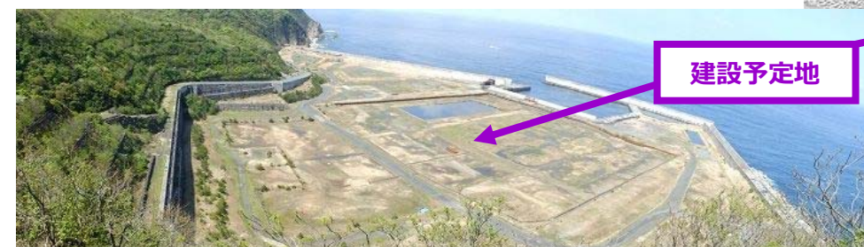
建設予定地の状況 (2024 年 4 月 25 日撮影)
