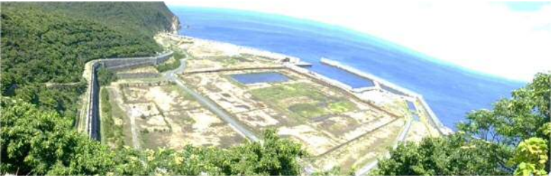
建設予定地の状況 (2024 年 7 月 26 日撮影)
