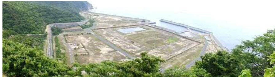
建設予定地の状況（2024 年 8 月 19 日撮影）
