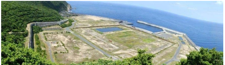
建設予定地の状況 (2025 年 7 月 15 日撮影)
