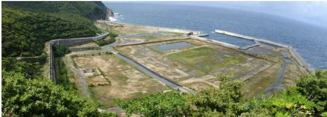
建設予定地の状況（2025 年 9 月 29 日撮影）
