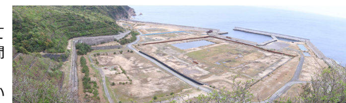
建設予定地の状況 (2026年4月22日撮影)
