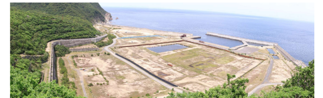
建設予定地の状況（2026年5月26日撮影）
