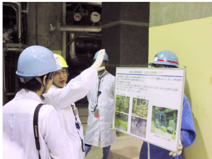
給水加熱器の跡地での説明
