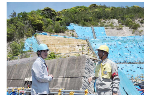
破砕帯調査現場にて寺谷所長より説明
