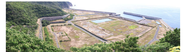
建設予定地の状況(2026 年 7 月 27 日撮影)
