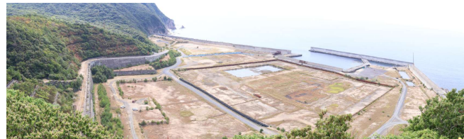
建設予定地の状況（2026 年 8 月 26 日撮影）
