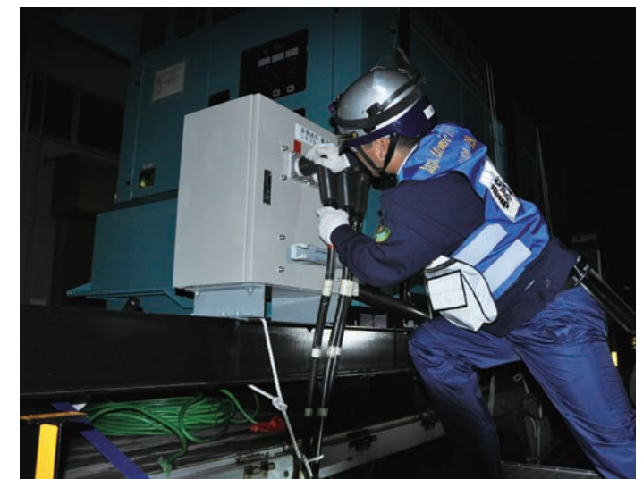
電源ケーブルのつなぎ込み訓練(夜間)
