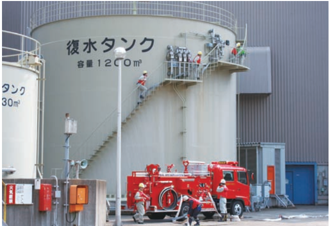
復水タンクへの給水訓練
