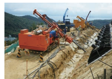
地滑り対策工事の施工状況
