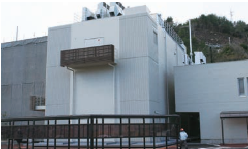
緊急時対策室建屋を新設
