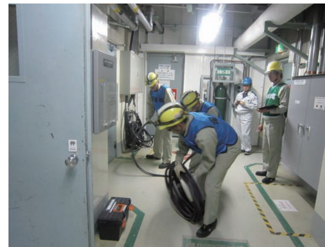
所内電源盤へのケーブル引き回し訓練
