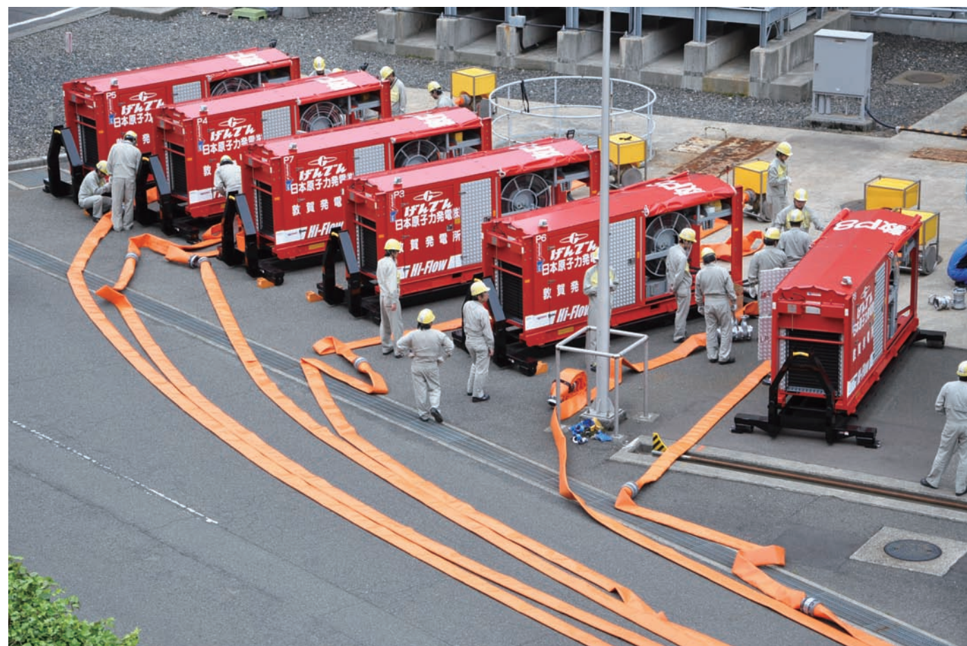
大容量ポンプの操作訓練
