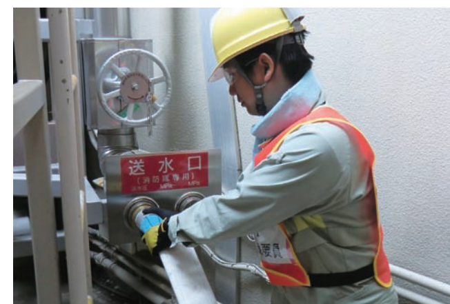
専用配管（屋外）へのホースつなぎ込み訓練
