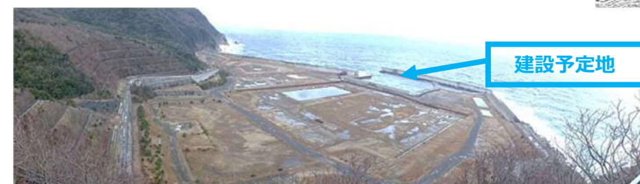
建設予定地の状況（2024 年 2 月 27 日撮影）
