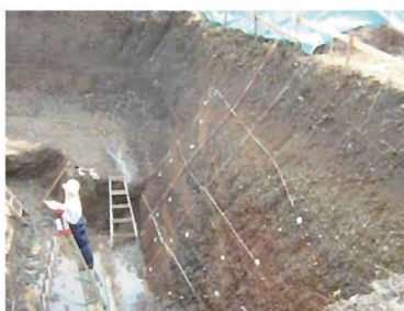
(トレンチ調査の例)
