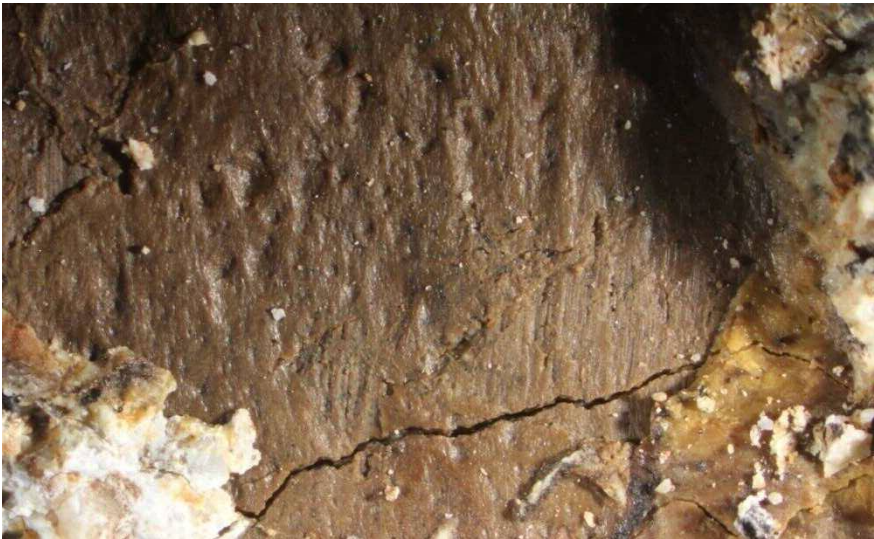
西側から東方を見る。西傾斜の断層面(A面)の下盤側表面の形態。高角度の条線が認められる。
