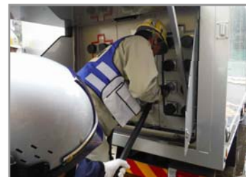
電源車に供給用 ケーブルを接続
