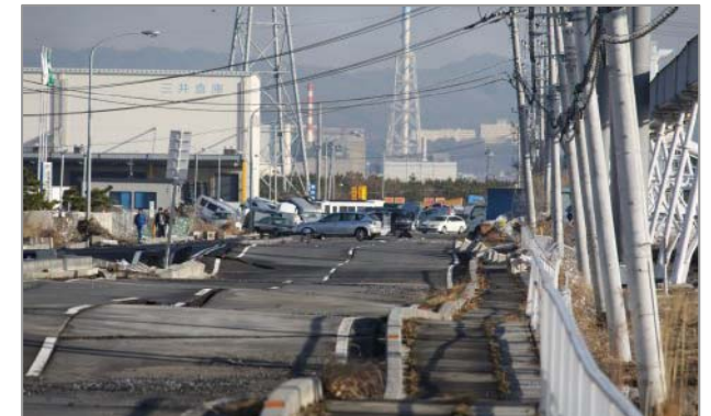
村内地震影響（道路）
