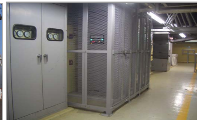
原子炉隔離時冷却系制御装置の高所移設
