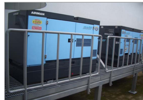
原子炉隔離時冷却系用エンジン発電機の追設
