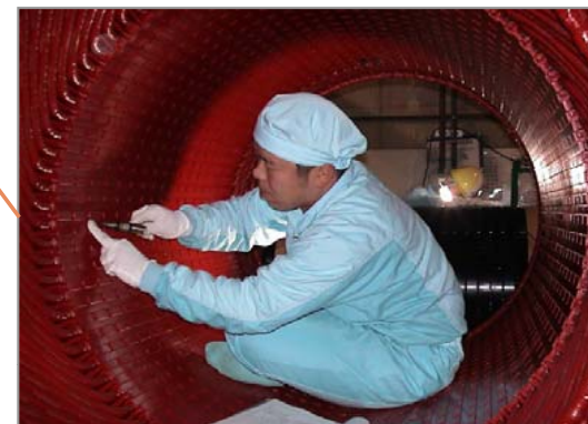
保守直営工事状況 （高圧復水ポンプ用電動機点検）
