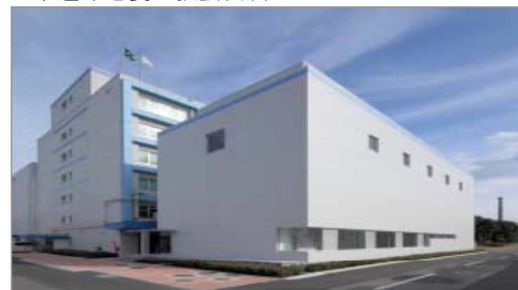
緊急時対策室建屋（屋上：ガスタービン発電機）
