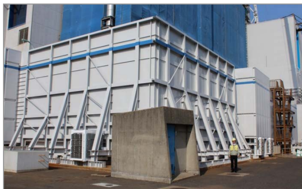
非常用DG給排気設備防護壁の設置
