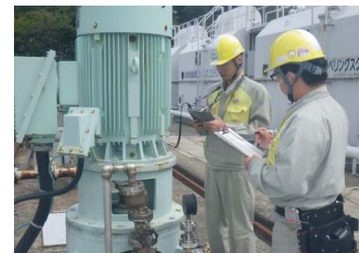
【直営での回転機振動測定】
