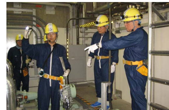
【副社長、常務による現場点検の状況】
