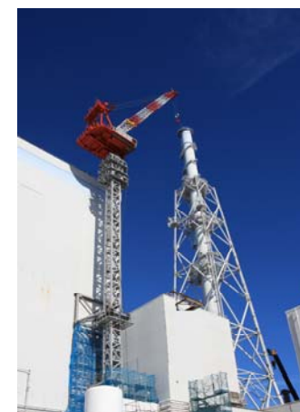
揚重作業用 タワークレーン設置
