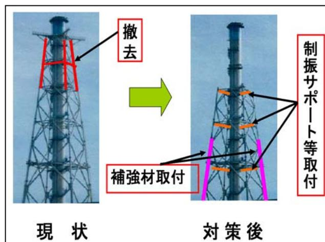
主排気筒補強工事の概要
