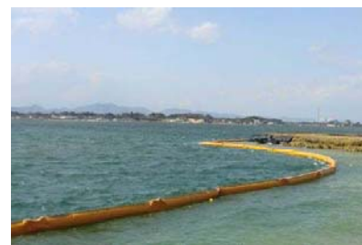
海洋への拡散抑制設備（汚濁防止膜）
