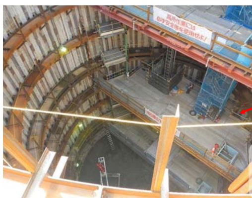
SA用海水ピット, SA用海水ピット取水塔設置
