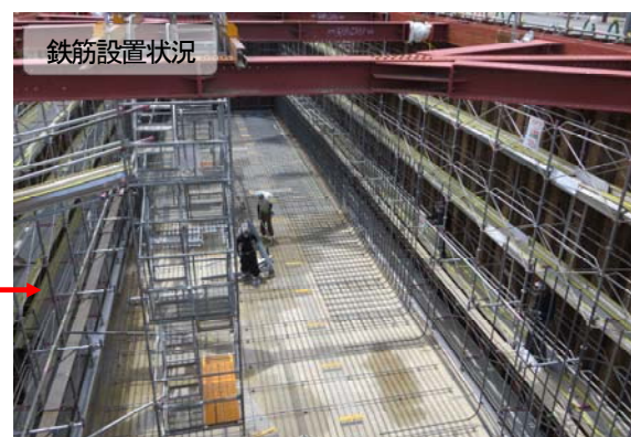
重油貯蔵タンク地下設置(躯体工)
