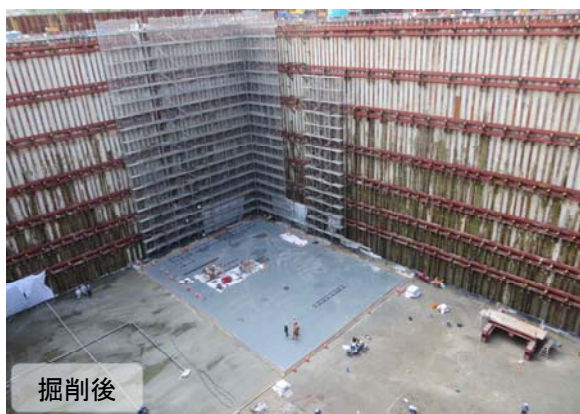
常設代替高圧電源装置置場(掘削)
