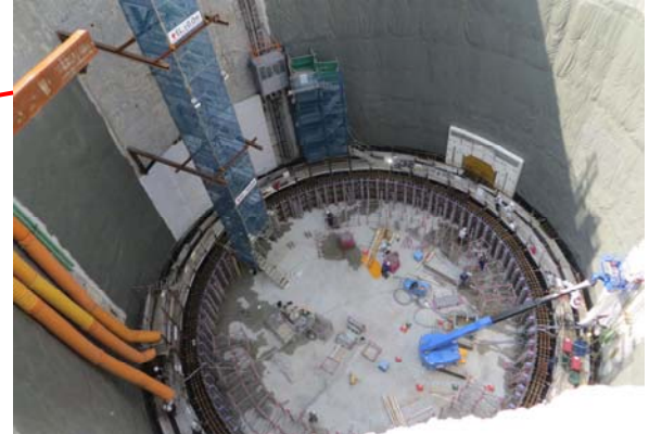
代替淡水貯槽 (鉄筋設置・コンクリート打設状況)
