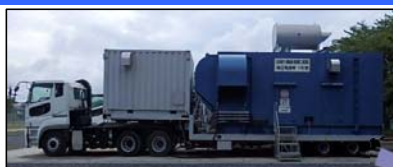
常設代替高圧電源装置 及び同置場
