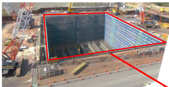
現在の工事状況
