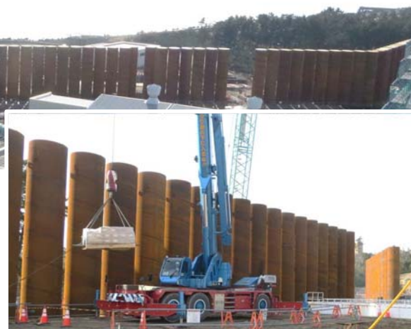
防潮堤(南側)の設置状況
