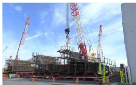
連続地中壁基礎として設置予定の鉄筋カゴ
