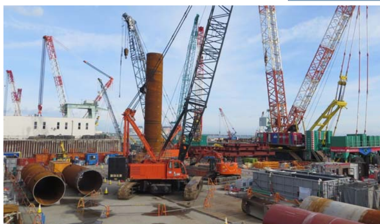
防潮堤(東側)の設置状況
