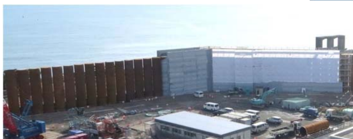
防潮堤(南東側)の設置状況
