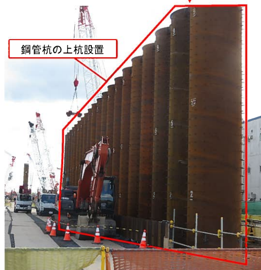
防潮堤(北側)の状況
