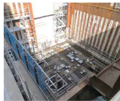
鉄筋設置状況（2022年7月）
