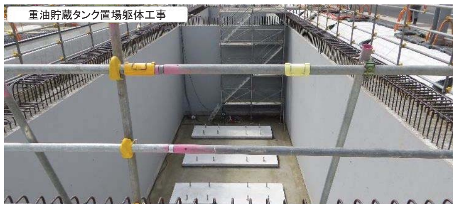
重油貯蔵タンク地下設置(躯体工)
